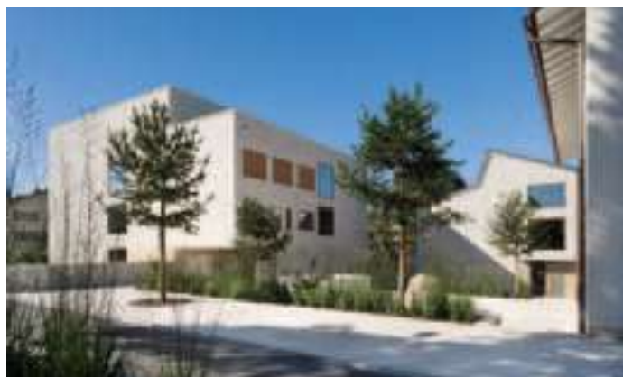
Neubau mit zwei sanierten Liegenschaften und dem Innenhof
