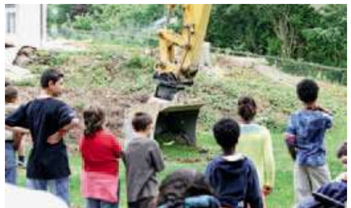
Spatenstich mit Bagger
